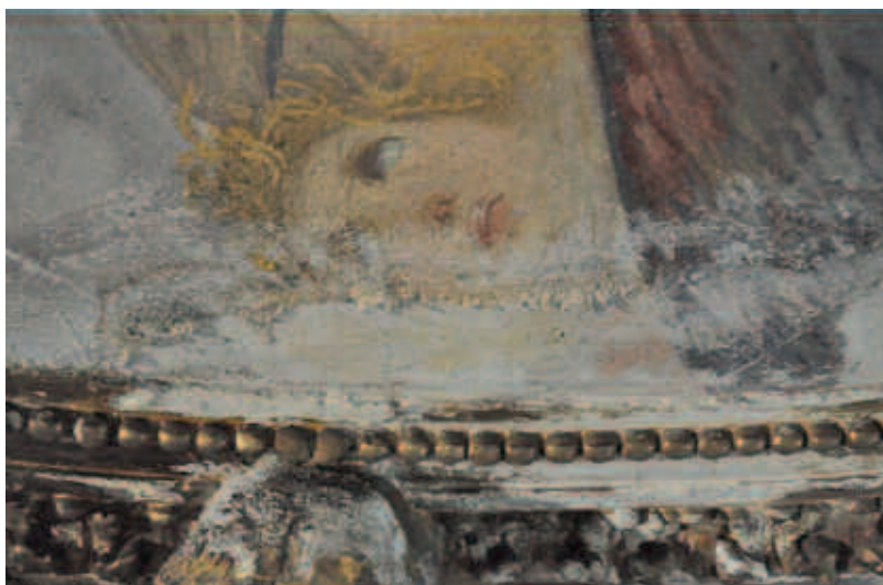
Dipinto di R. Resio, particolare di zona altamente degradata
