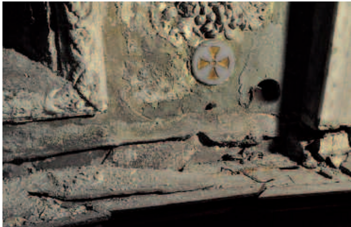
Particolare di zona altamente degradata in prossimità del coro, prima dell'intervento di restauro
