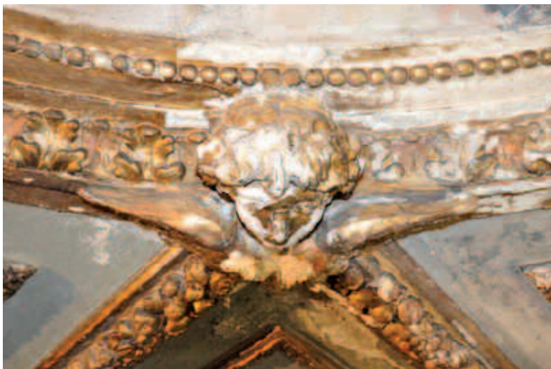
Particolari di stucchi dorati altamente degradati
