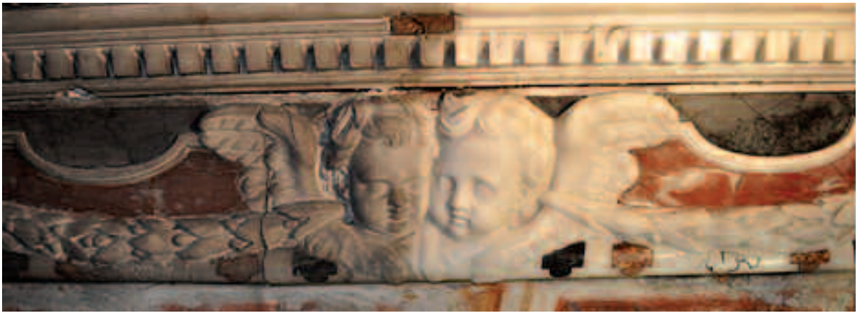
Particolare di prova di pulitura dei marmi della cappella di N.S. di Caravaggio
