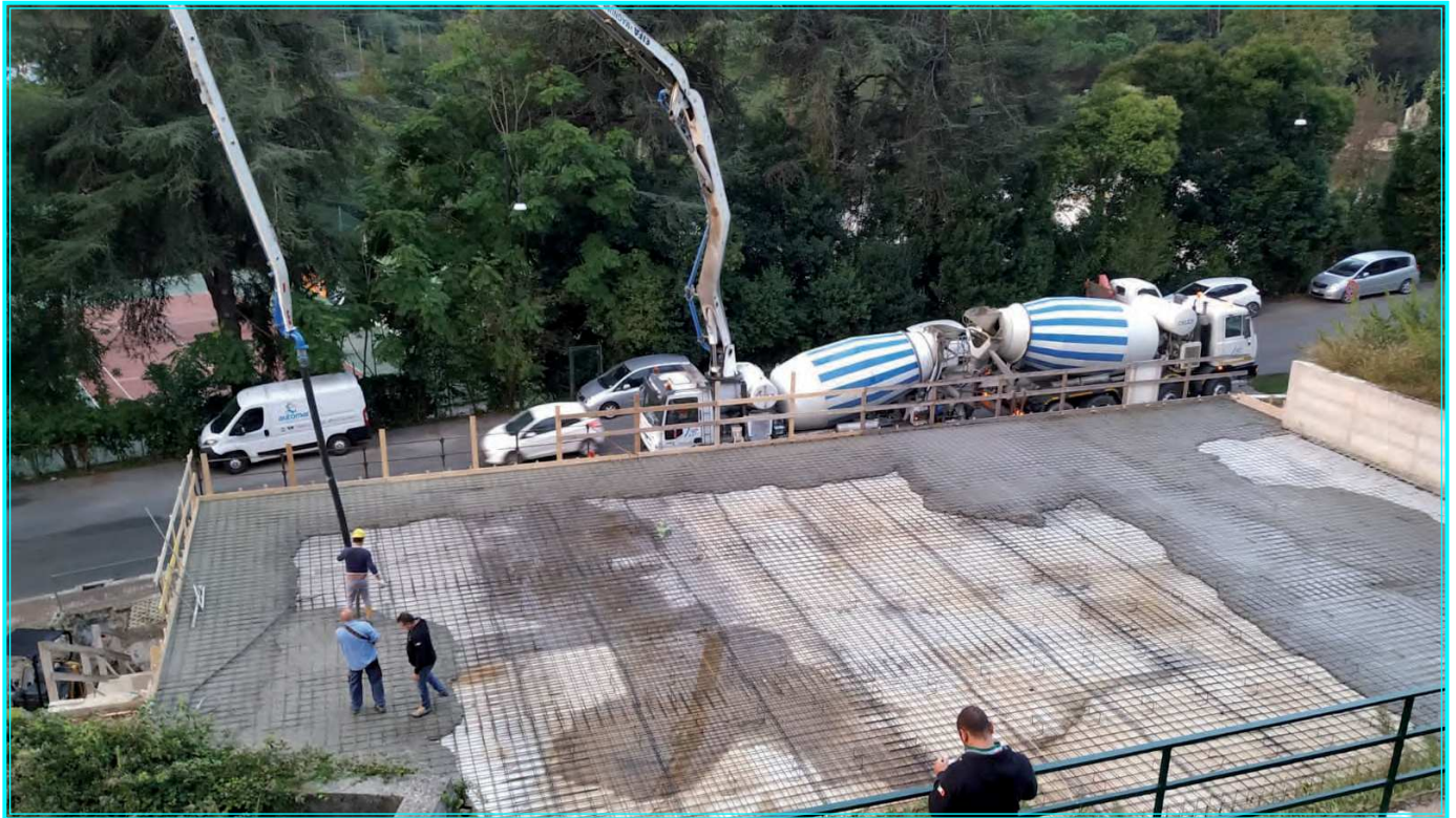
Nella foto sopra: un momento fondamentale della costruzione del campetto: la gettata del solettone
